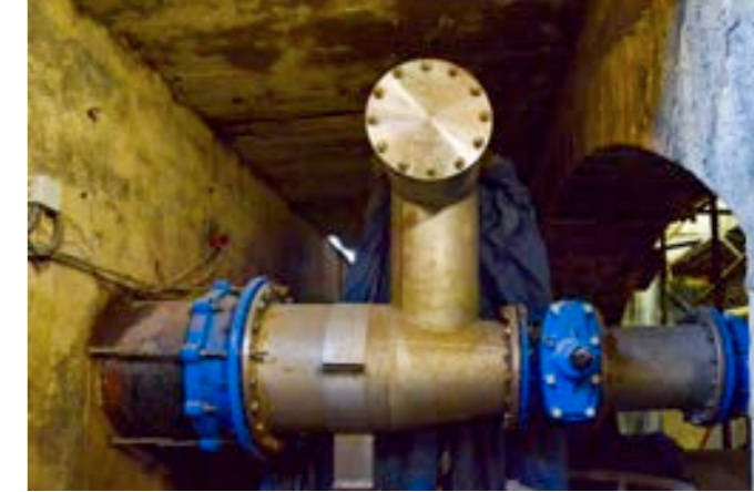
Un by-pass a été posé pour permettre de réaliser les travaux sans coupure d'eau
