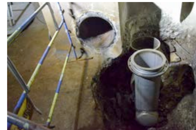
Toutes les canalisations ont été renouvelées par des conduites en inox
