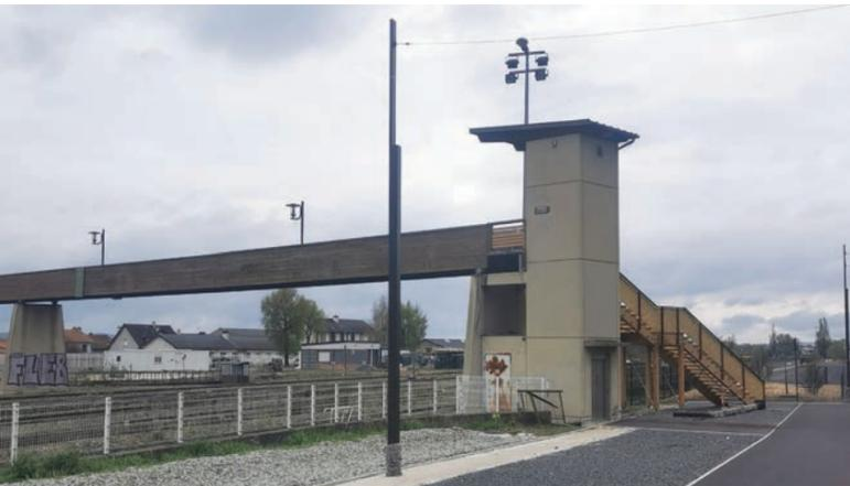
L'avancement du chantier du Pôle d'Échange Intermodal a nécessité à plusieurs reprises la fermeture de la **passerelle de la gare**. En cohérence avec l'aménagement du site, l'escalier d'accès a été déconstruit pour être positionné côté gare routière. Il atterrit sur le nouveau cheminement piéton. Des finitions sont apportées, notamment pour l'habillage des garde-corps et la glissière à vélo.
